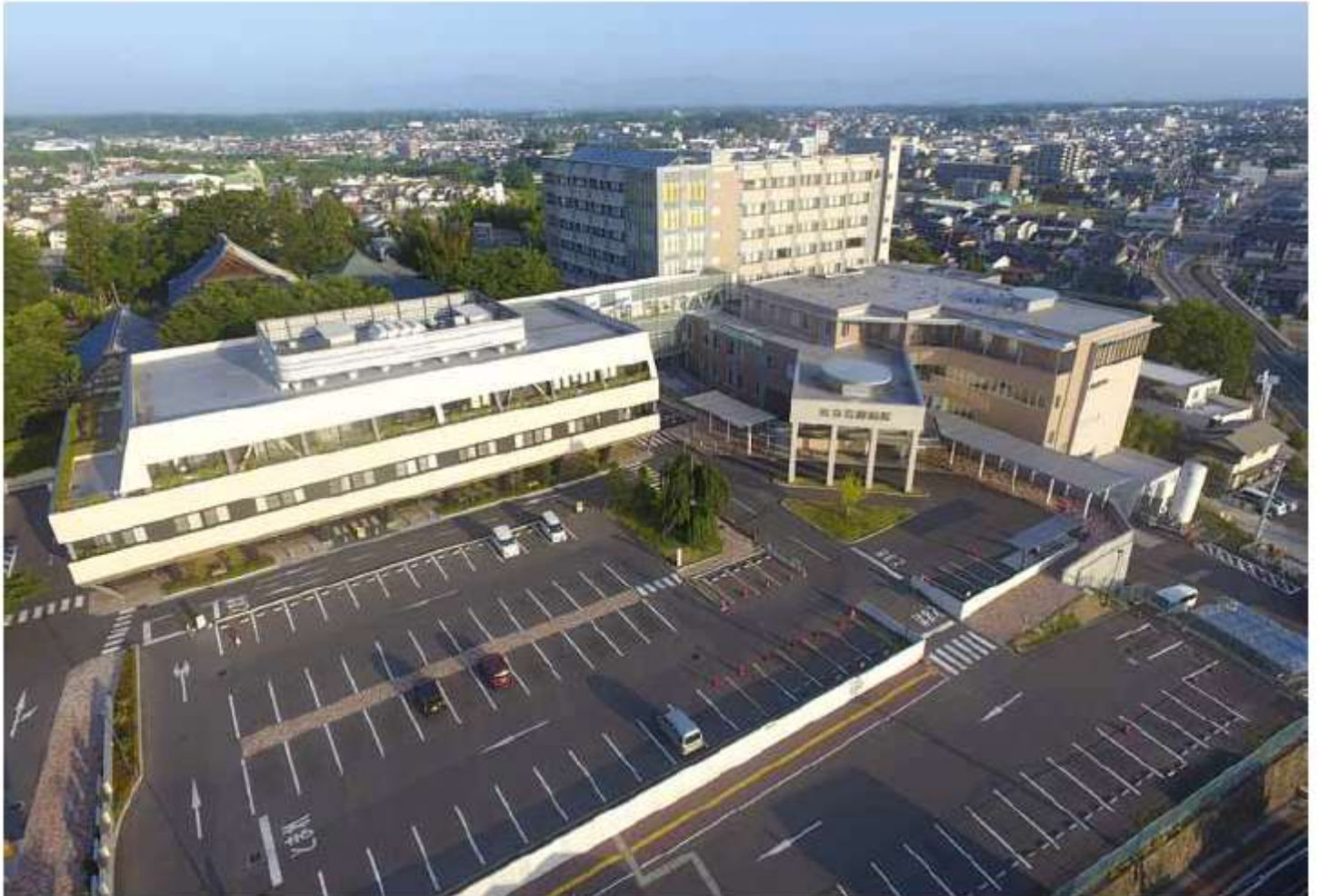
上空から見た病院の全景
